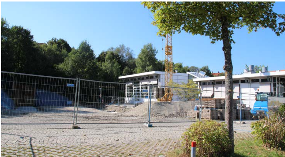
Foto: Baustelle der neuen Maschinenhalle der Fakultät Maschinenbau auf dem südlichen Campus vor der Dr.-Hans-Liebherr Halle
